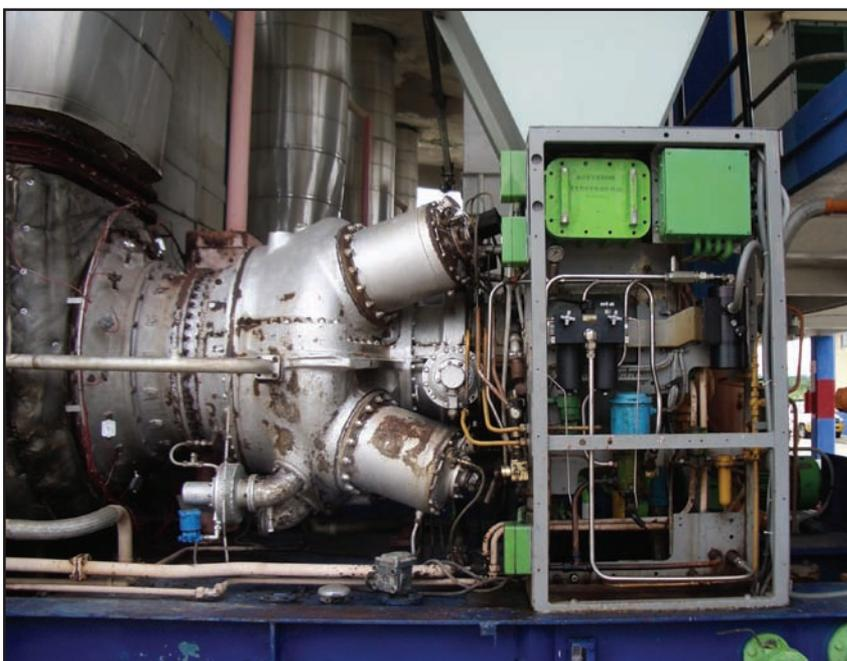
■ Aquí se muestra una turbina a gas Ruston TB-5000 con la ALV 10 (válvula líquida) de Continental Controls Corporation y un módulo de doble filtro.
