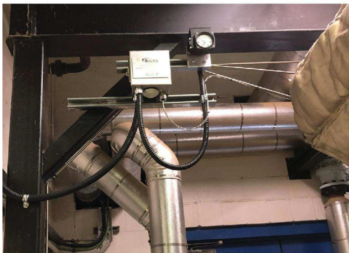
Una sección del dispositivo de medición de flujo de gas FM 50
